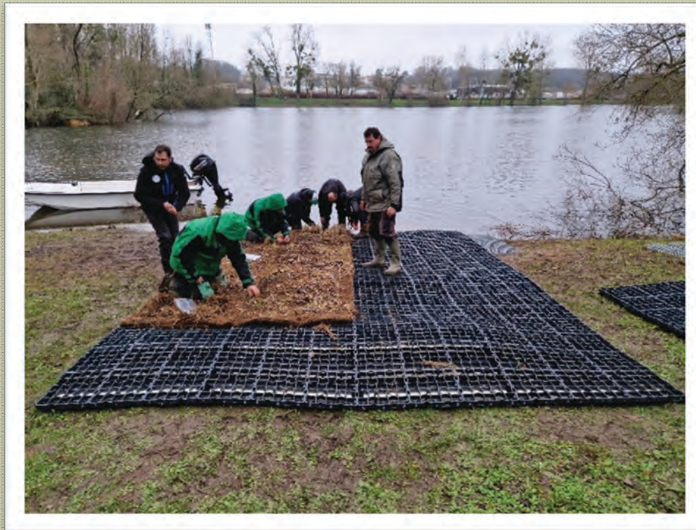
Assemblage de la structure et pose de la géonatte pré-végétalisée
